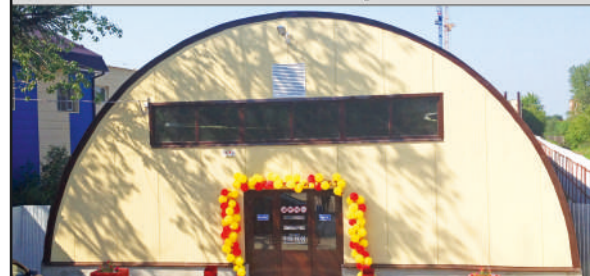
СКЛАДСКИЕ И ПРОИЗВОДСТВЕННЫЕ ПОМЕЩЕНИЯ
